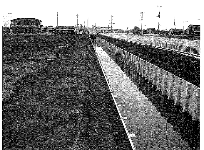
側排水路補修工事 (加須市大字大越地内) (改修後)
