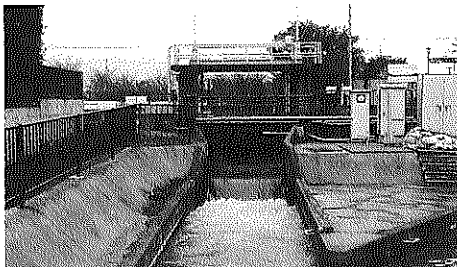
○埼玉用水路から取水する最初の分土工であり、羽生領区域を流下する南方用水路に分水している。
