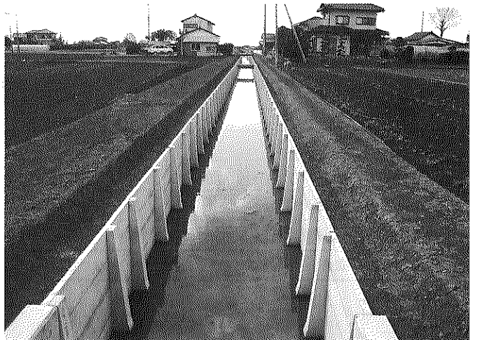
沼田落排水路改良工事(加須市外記新田地内) (工事後)
