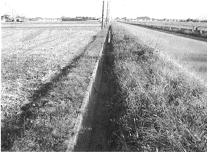
新農業水利システム保全対策事業 (工事前)
