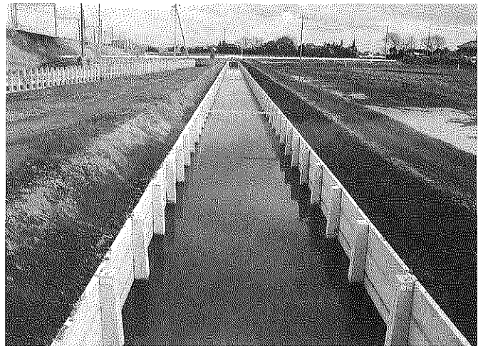
堤根落排水路改良工事(加須市旗井・外記新田地内) (工事後)
