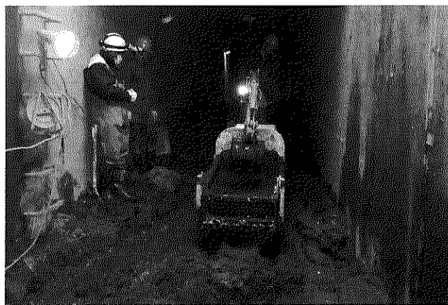
◎金野井揚水機場江戸川樋管内浚渫作業
