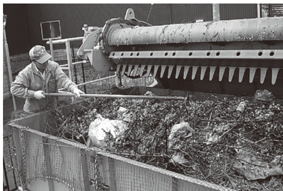
◎島中領幹線用水路(高柳分水堰)
