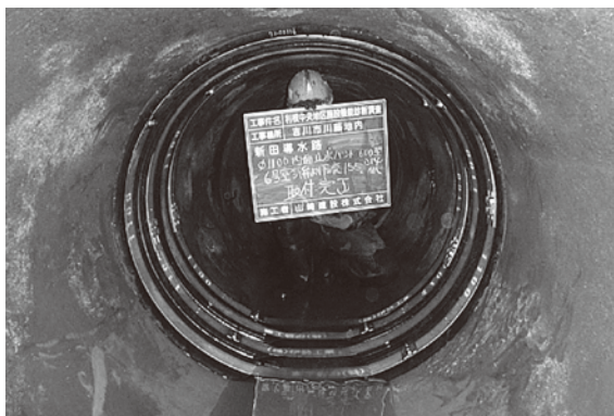
◎新田導水路(Ø1100)管継手補修
