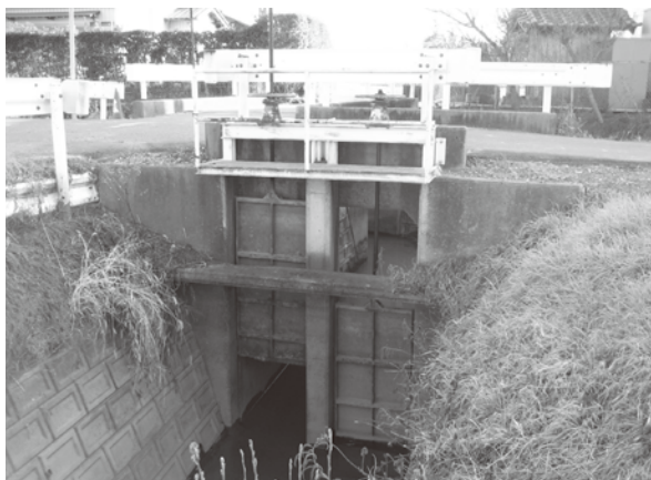
●土地改良施設維持管理適正化事業 (工事前)
