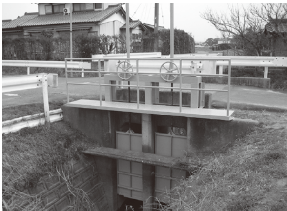
松原堰補修工事(加須市北篠崎地内) (工事後)
