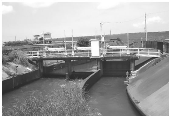
○佐波分水堰(加須市外野地内)
