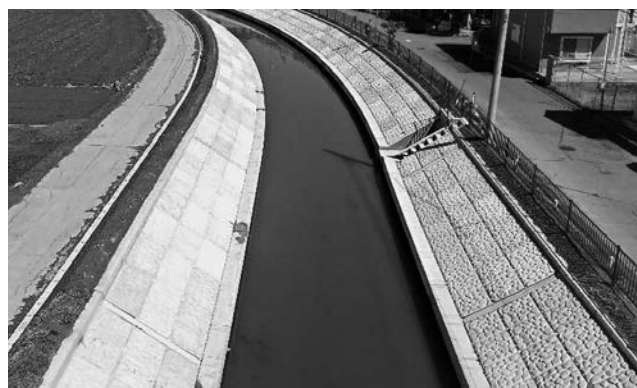
◎県営農地防災事業（湛水防除）稲荷木落排水路 【加須市旗井地内】
